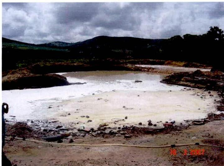
Figura 3.10 - Deposição da manipueira em escavação, Girau do Ponciano, AL.
