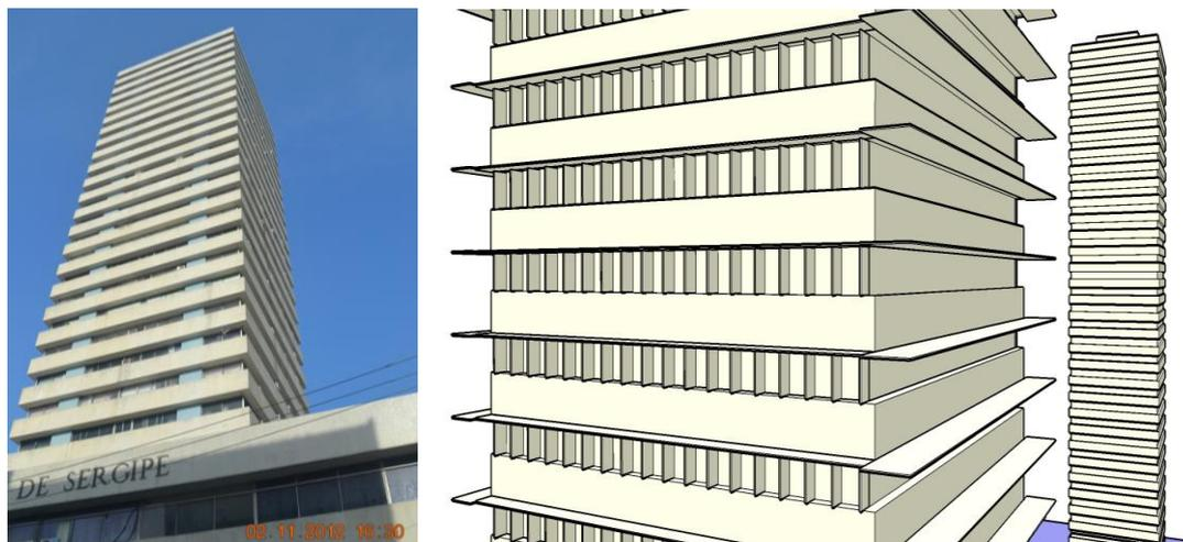
Figura 20. Edifício Estado de Sergipe - SE. Simulação de protetores para a fachada Norte.
