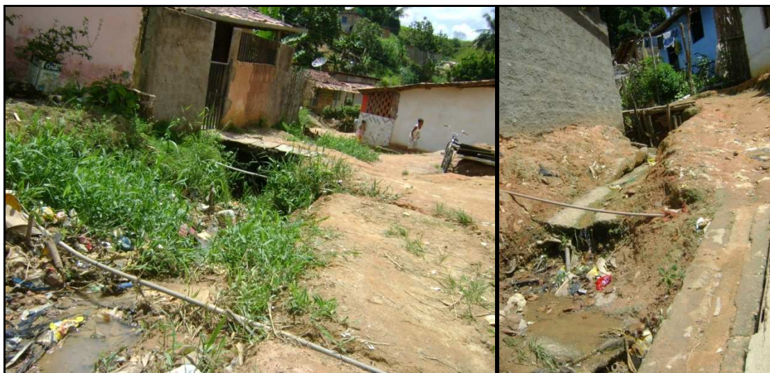
Figura 50: Tubulação de água passando em meio a esgoto a céu aberto, Maceió – 2011
