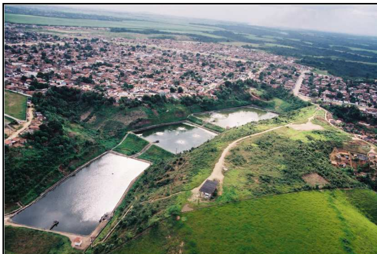
Figura 19: Lagoas de estabilização do Benedito Bentes, Maceió
