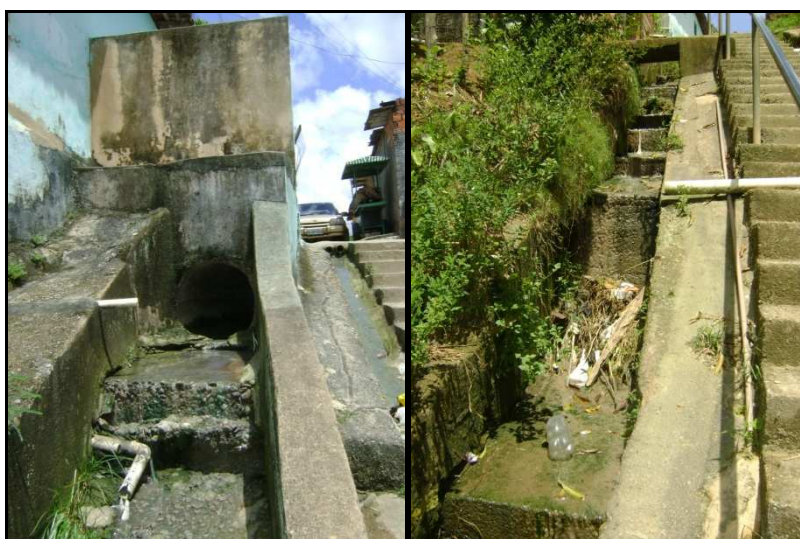
Figura 48: Esgoto a céu aberto em galeria de água pluvial e calhas superficiais no Benedito Bentes, Maceió – 2011
