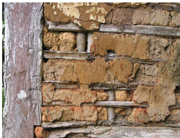
Figura 7: Detalhe de parede em taipa de pau-a-pique
