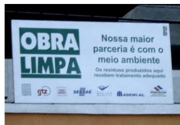
Figura 18: Placa com apelo ambiental na obra de um edifício em Maceió-AL.
