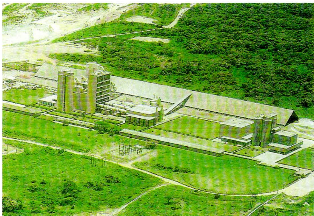
FIG. 17- COMPANHIA DE CIMENTO ATOL Fonte: TRABALHO DE CAMPO
