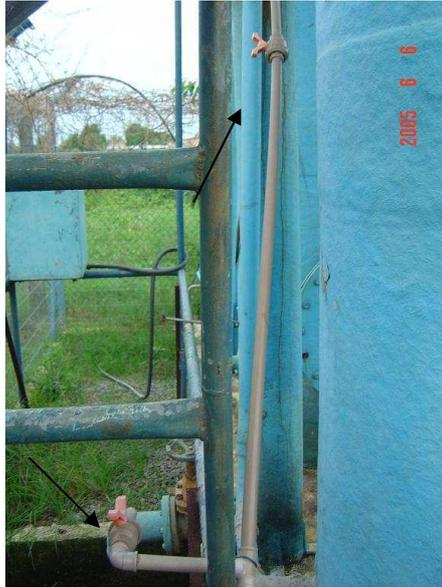
**Figura 4.4** – Sistema de registros para coleta antes da caixa de areia
