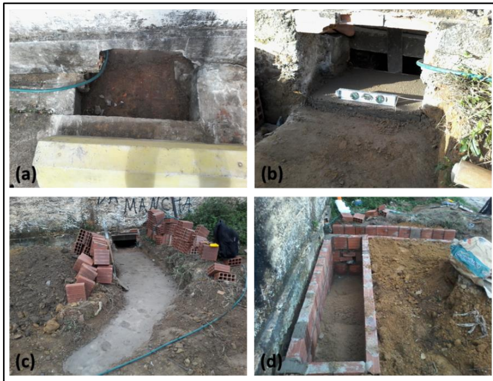
Figura 14 – Execução da infraestrutura do amostrador
