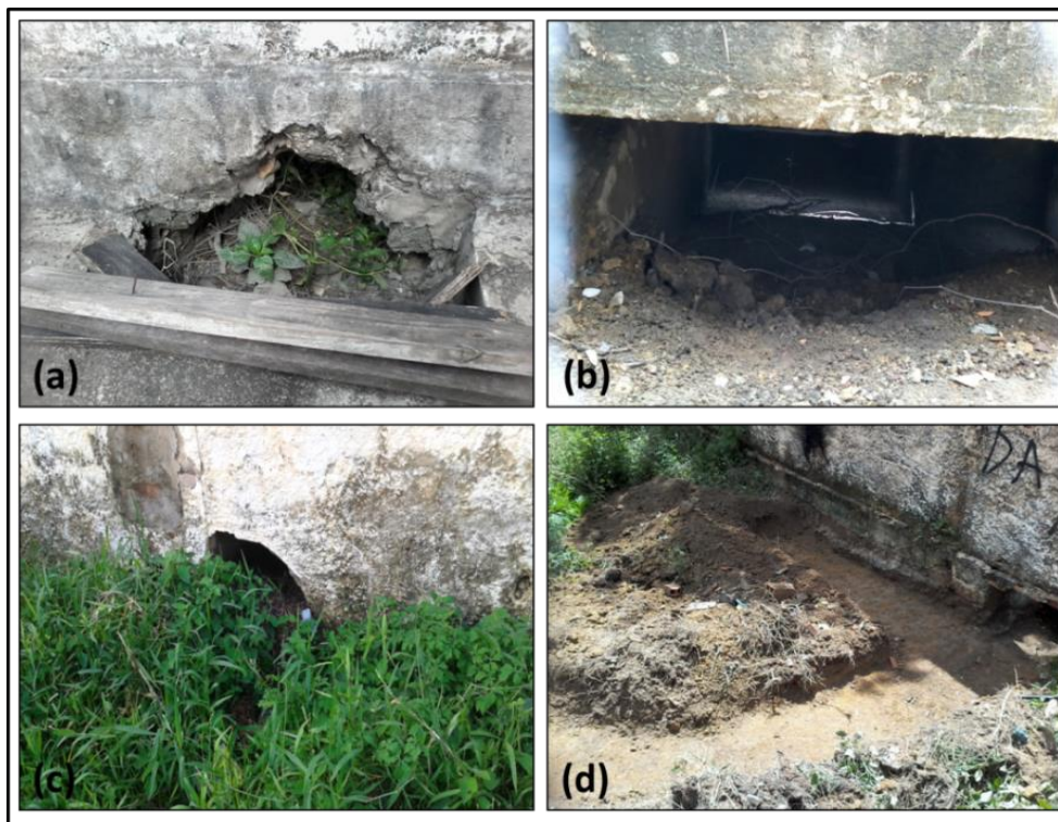
Figura 13 – Galeria de drenagem antes da intervenção (a) e (c) e depois (b) e (d).
