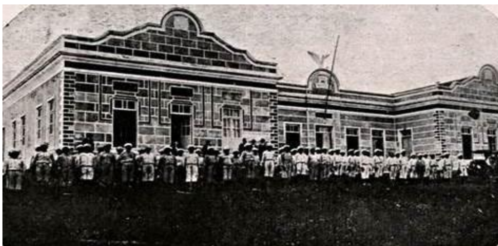
Figura 22 – O edifício do Patronato de São Maurício
