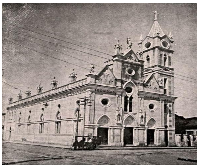
Figura 34 – Igreja de São Salvador recém-reformada
