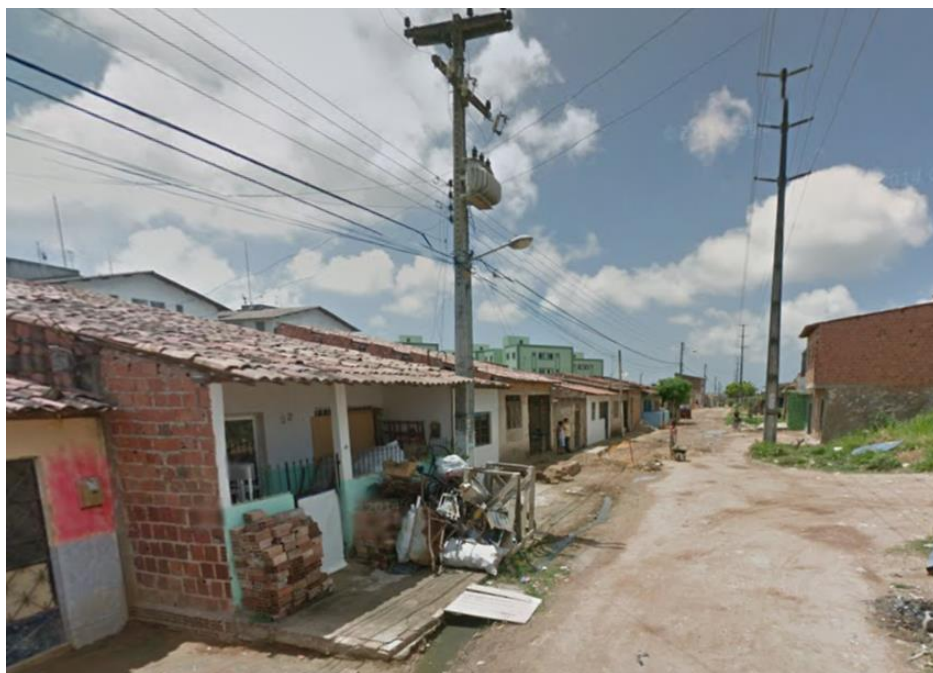
Figura 10 - Falta de Saneamento no Conjunto Vitória. Fonte: Google Earth, 2015.
