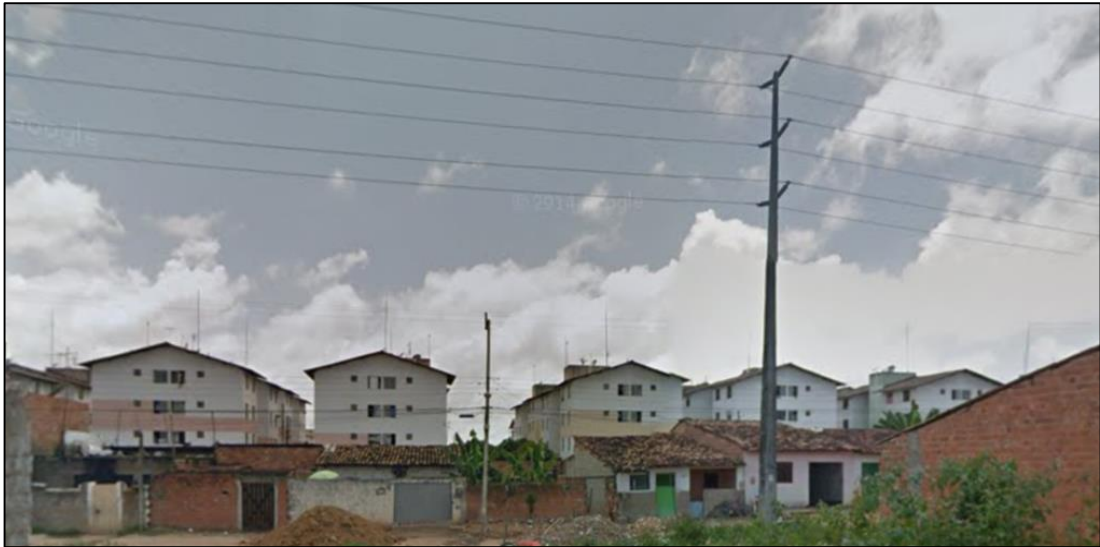
Figura 4 - Alinhamento do assentamento com a rede de alta tensão. Fonte: Google Earth, 2015.
