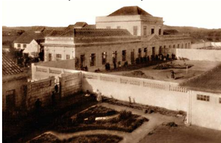
Figura 9: Hospital Psiquiátrico São Pedro, em Porto Alegre, 1886, em construção, onde pode-se ver o pátio central, nesta época, chamado de Hospício de São Pedro.
